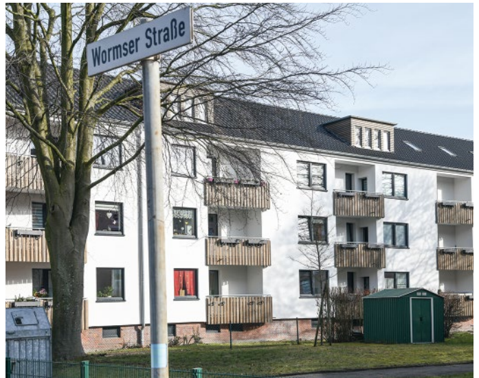
Abgeschlossene Sanierung in der Wormser Straße
