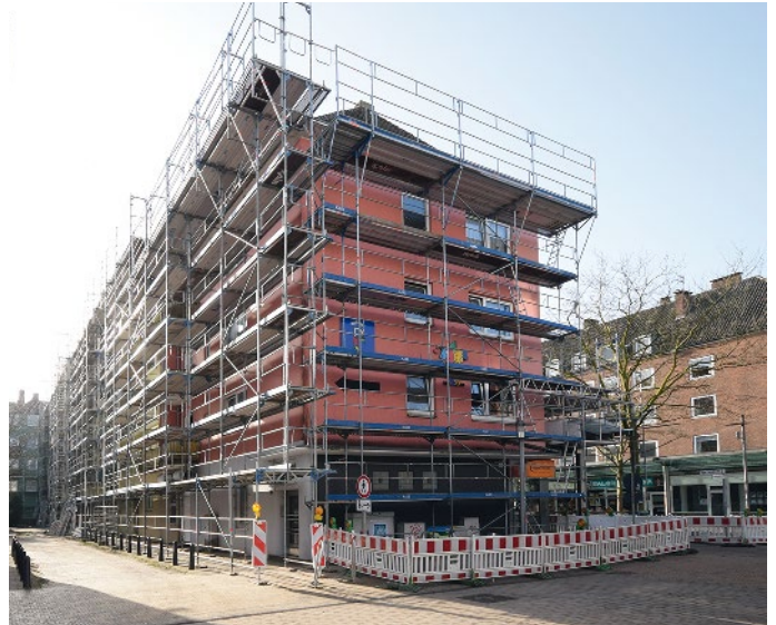
Aufbau des Gerüsts in der „Bürger“ 73–83
